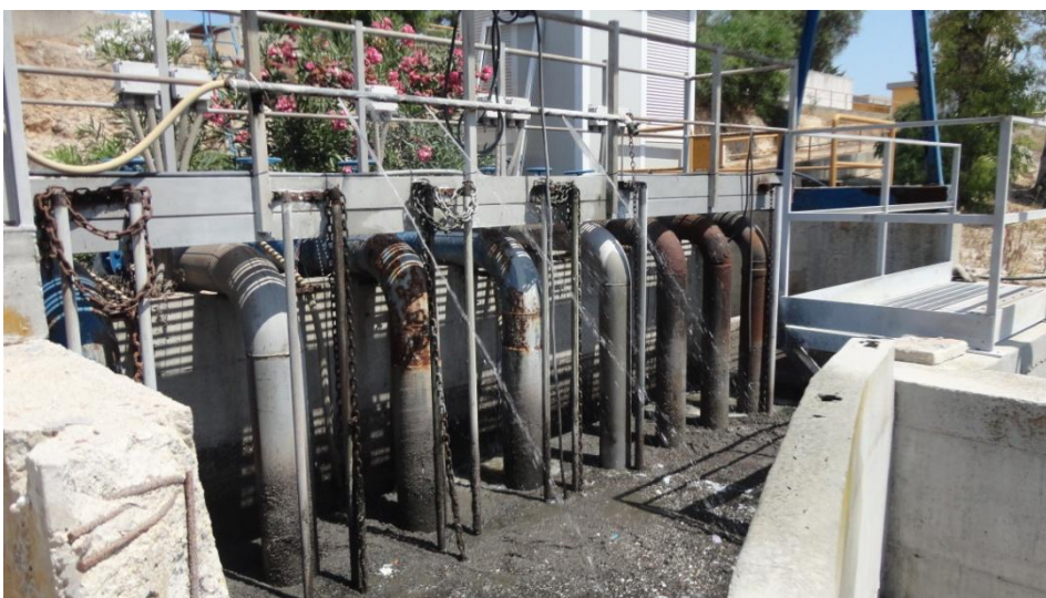
Foto n. 6: Sollevamento liquami equalizzati
