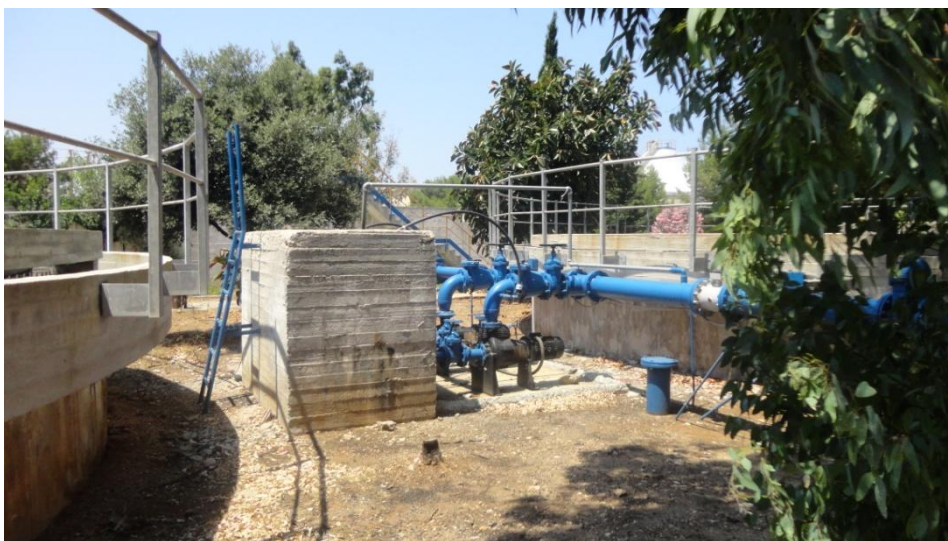
Foto n. 13: Sollevamento fanghi di ricircolo e supero da sedimentatori finali: “ linea vecchia ”
