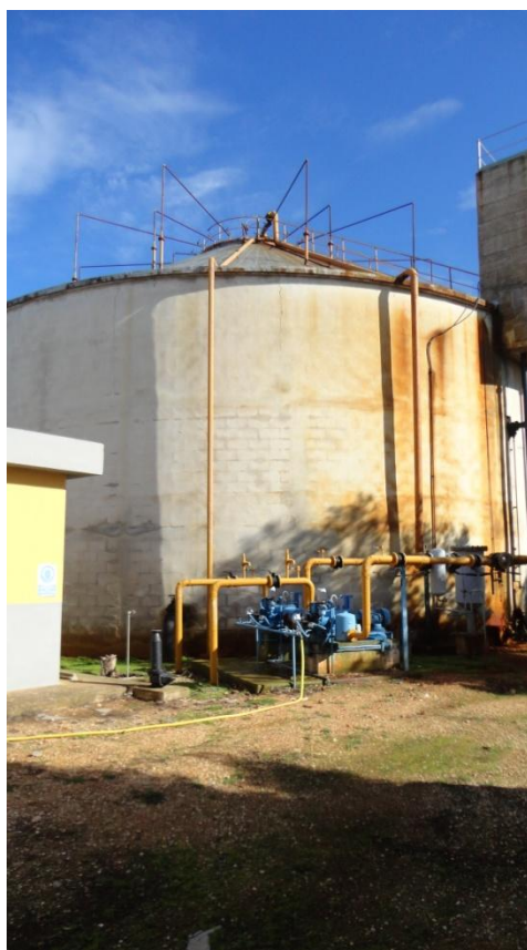
Foto n. 20: Digestore anaerobico primario
