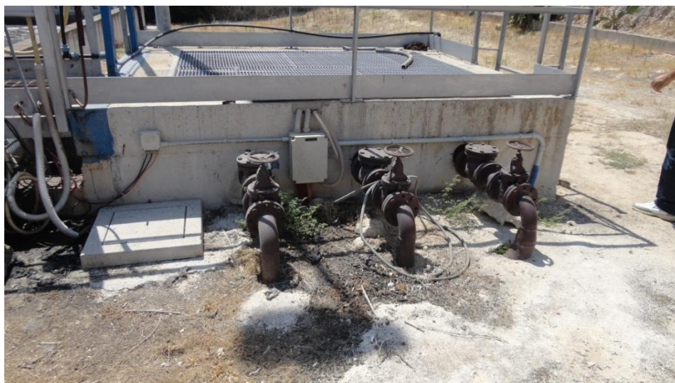
Foto n. 7: Sollevamento fanghi di supero provenienti dalla “linea nuova”
