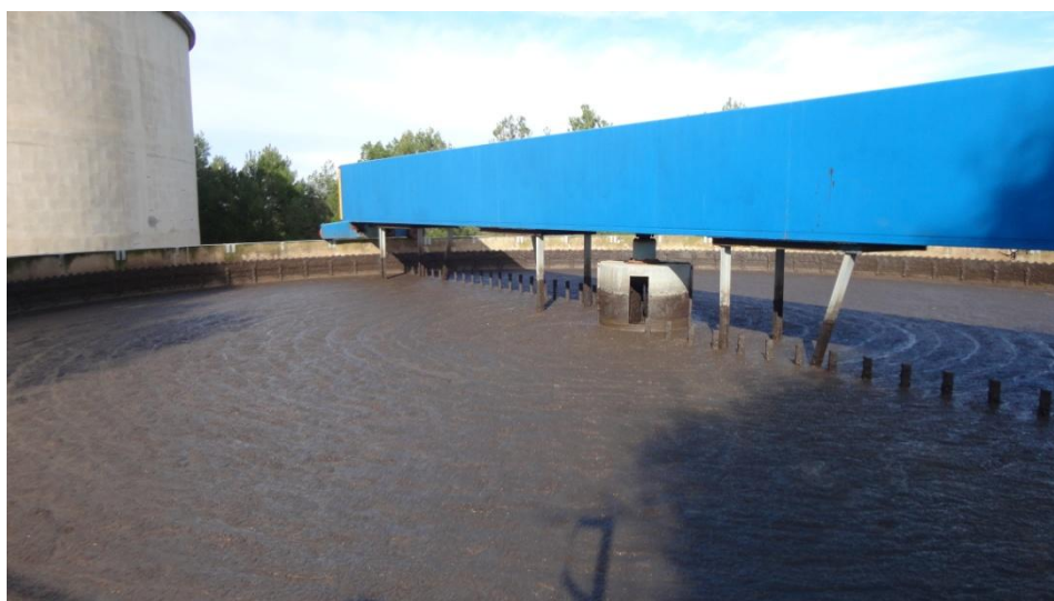
Foto n. 19: Bacino di pre-ispessimento fanghi
