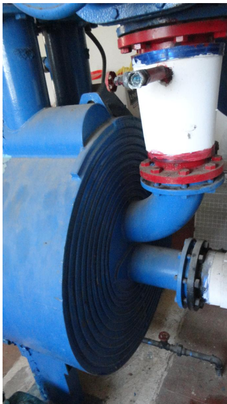
Foto n. 29: Locale centrale: scambiatore di calore (non in esercizio)
