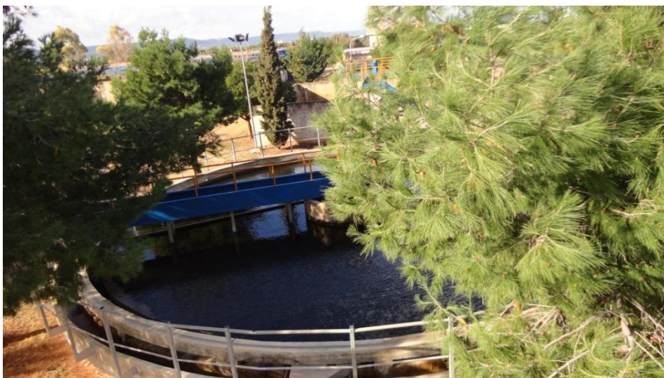
Foto n. 14: Sedimentatore finale: “ linea vecchia ”
