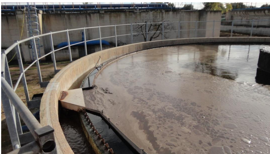
Foto n. 17: Sedimentatore finale: “linea nuova”
