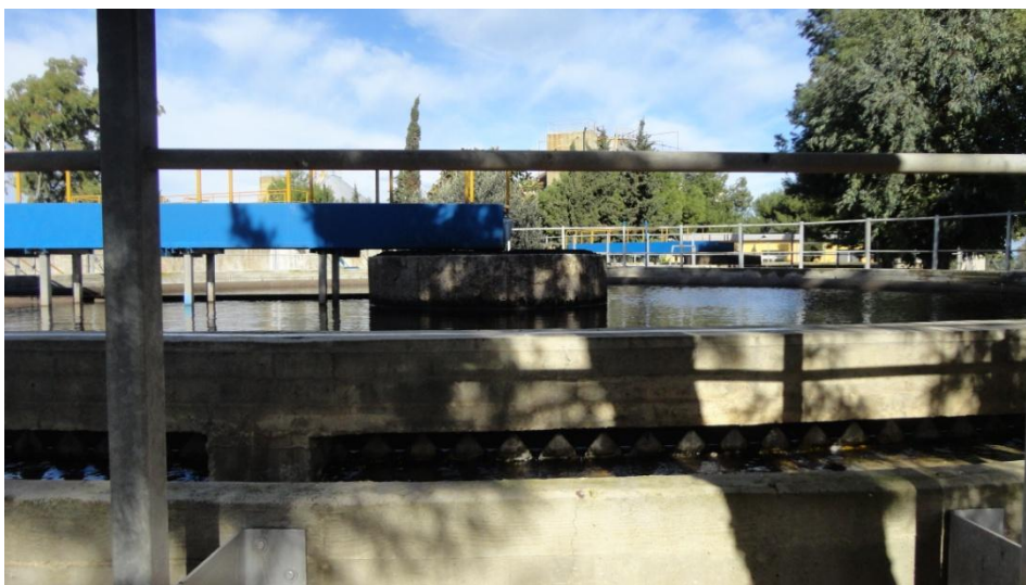
Foto n. 15: Sedimentatore finale: “ linea vecchia ”
