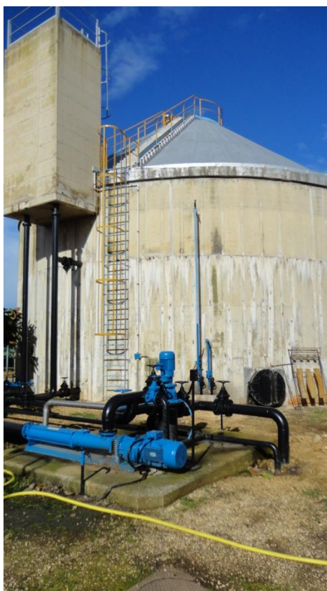
Foto n. 24: Digestore anaerobico secondario
